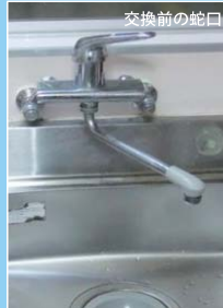
交換前の蛇口
